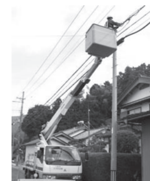
光ファイバー敷設工事
