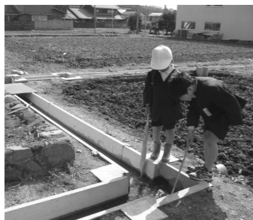
① 農業用水路の整備
