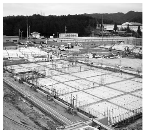
① 工事が進む貴生川小学校(上)と小原小学校(下)
