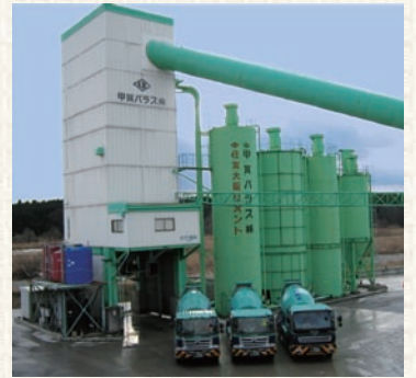
▲生コンバッチャープラント
